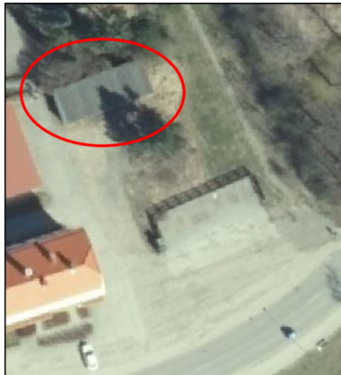
Bild 10: Garaget som tidigare fanns på platsen där parkeringsplats nu anlagts (Ortofoto från 2017).
